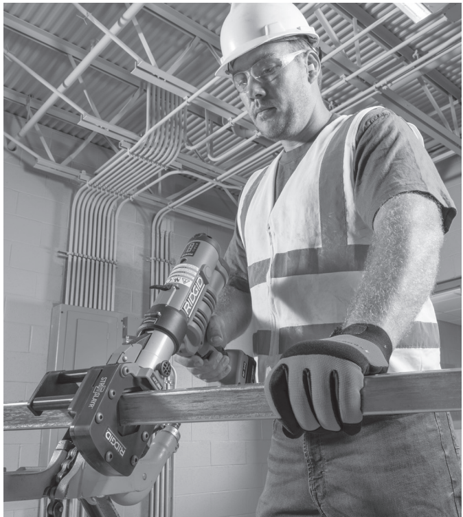
Figure 8 – Cisaille en cours d'opération
